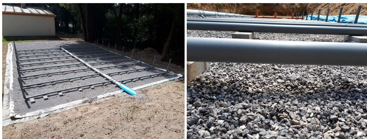
Obr. 22 Příklad realizace distribuční sítě [obr. 8]
